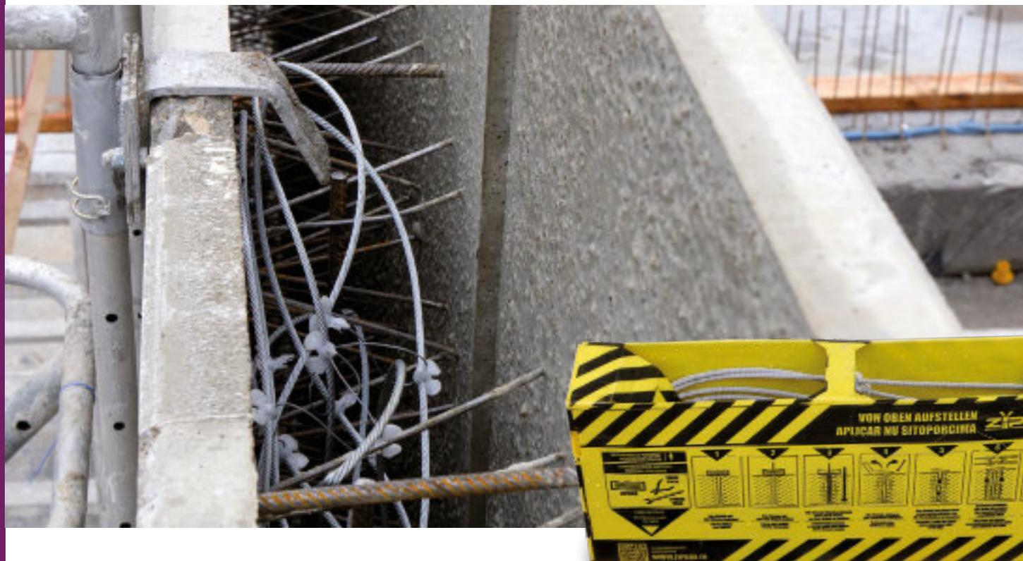
**La ZIPBOX est un nouveau système d'armature qui permet de « zipper » littéralement les prémurs. Une solution rapide, solide et sûre.**
