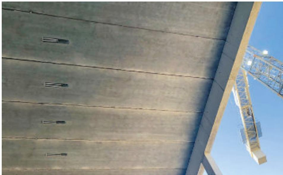
Le béton peut être rendu thermiquement actif en raison de son poids spécifique élevé. C'est ce qu'on appelle l'activation du noyau de béton. Le système ClimaDeck en fait usage et constitue donc un système de construction durable qui allie économies d'énergie et confort. Raf Poppe, qui était à l'avant-garde du développement du système ClimaDeck, est de retour chez ECHO pour reprendre ClimaDeck en mains. Nous souhaitons la bienvenue à Raf. Dans la prochaine édition d'Élément,
