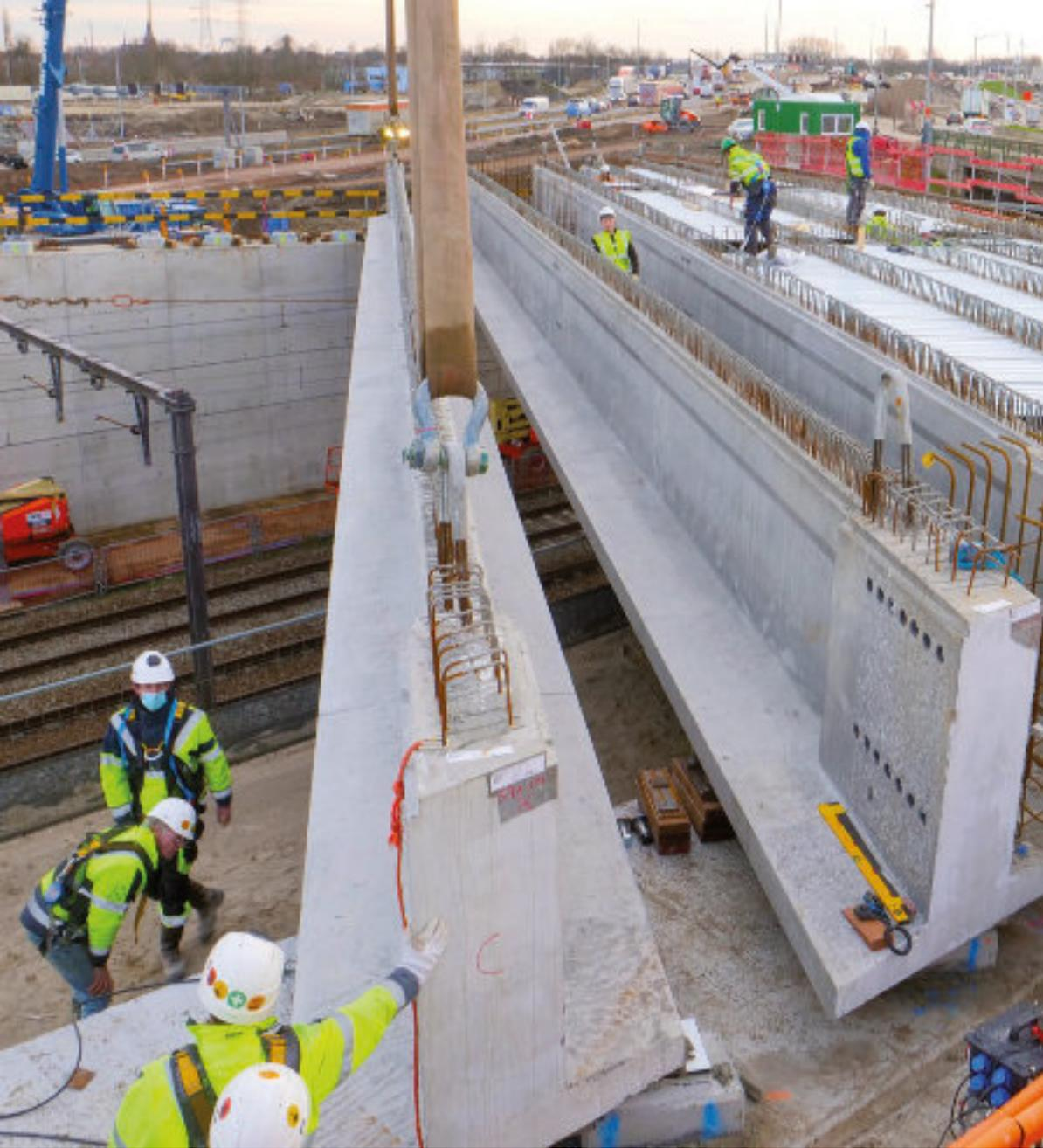
pont. Les joints entre les poutres ont été étré sillonnés par des coins de blocage pour garantir l'uniformité de leur largeur. Cela évite qu'ils ne s'étrécissent au centre de la portée en raison du cintrage des poutres du pont. Après un temps de durcissement suffisant, les traverses et le tablier forment un ensemble extrêmement rigide et les tendeurs peuvent alors être enlevés. »
